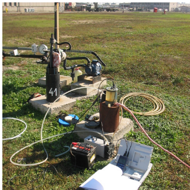
Monitorovací vrt s ukázkou kontinuálního měření procesních parametrů
