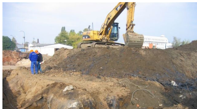
Odtěžba kontaminované zemin y
